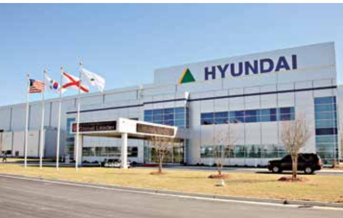
현대일렉트릭이 인수한 미국 앨라배마 변압기 생산 공장 전경
