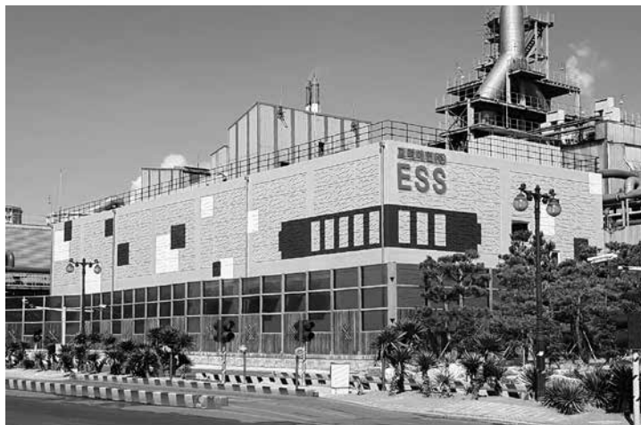
울산시 울주군 소재 고려아연 온산제련소에 조성된 세계 최대 150MWh 규모 ESS센터의 1공장 전경
